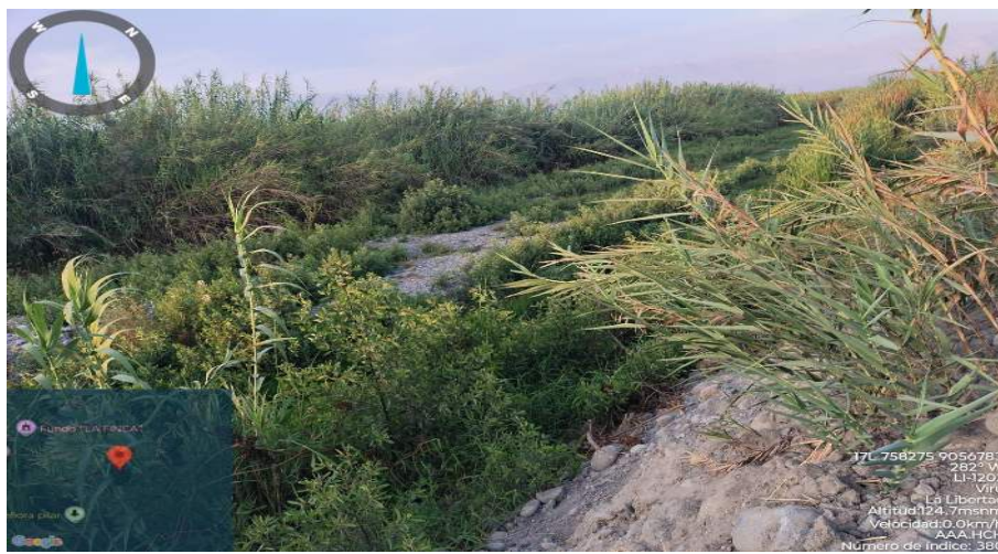
FIGURA N°01: TRAMO CRITICO RIO HUAMANZAÑA EN EL SECTOR SAN CARLOS BAJO II, SE APRECIA TRAMO COLMATADO CON BANCOS DE MATERIAL DE RIO Y MALEZA DENTRO DEL CAUCE
