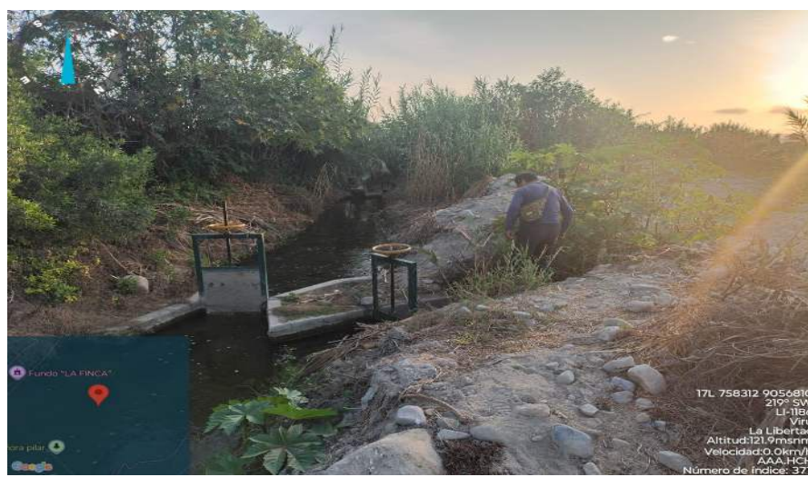
FIGURA N°02: TRAMO CRITICO RIO HUAMANZAÑA EN EL SECTOR SAN CARLOS BAJO II, SE APRECIA TRAMO COLMATADO PRESENCIA DE INFRAESTRUCTURA HIDRAULICA EXPUESTA EN CAUCE DEL RIO
